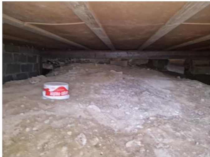
Vy i del av kryppgrund (under tillbyggnad)
