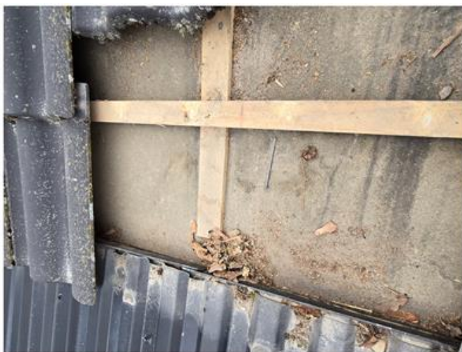
Stickprovskontroll under pannor, löv/barr samlas vid plåtuppvik.
