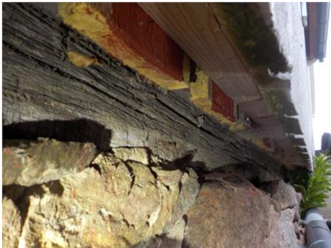
Tilläggsisolering mot tidigare bottenbrädor.
