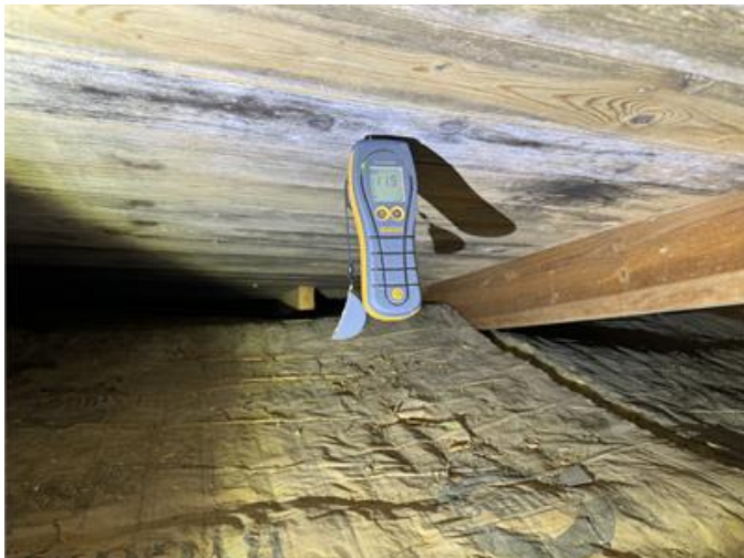
Fuktkvotsmätning i underlagstak "vind".
