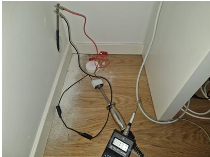
Fuktkvotsmätning i suterrängkällaren
