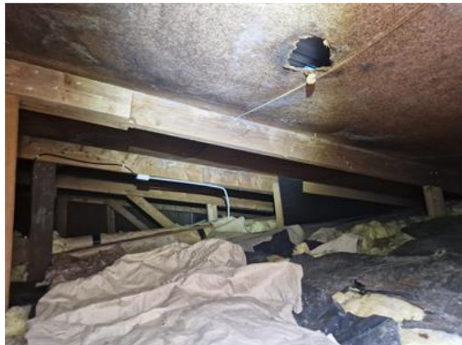
Vy på underlagstak
