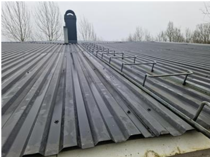
Vy på yttertak
