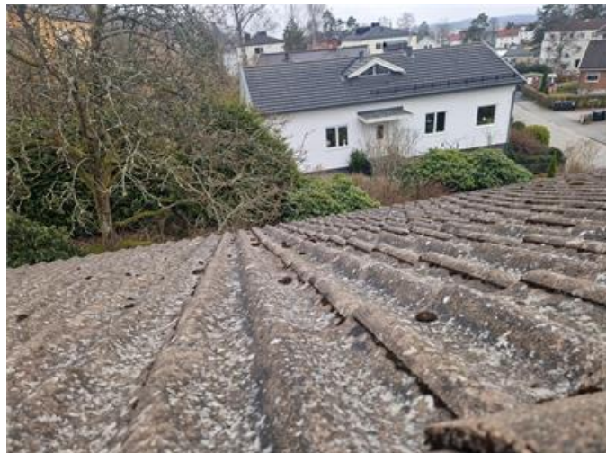
Vy på yttertak
