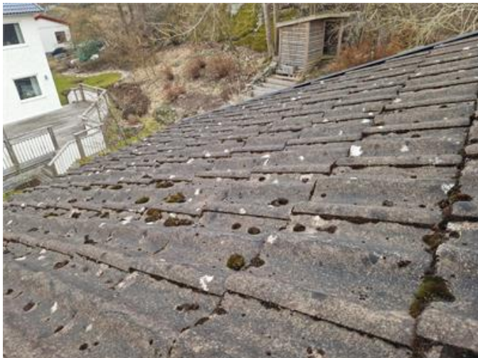
Vy på yttertak
