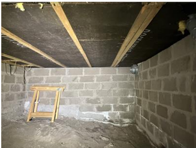
Bilden från krypgrunden.
