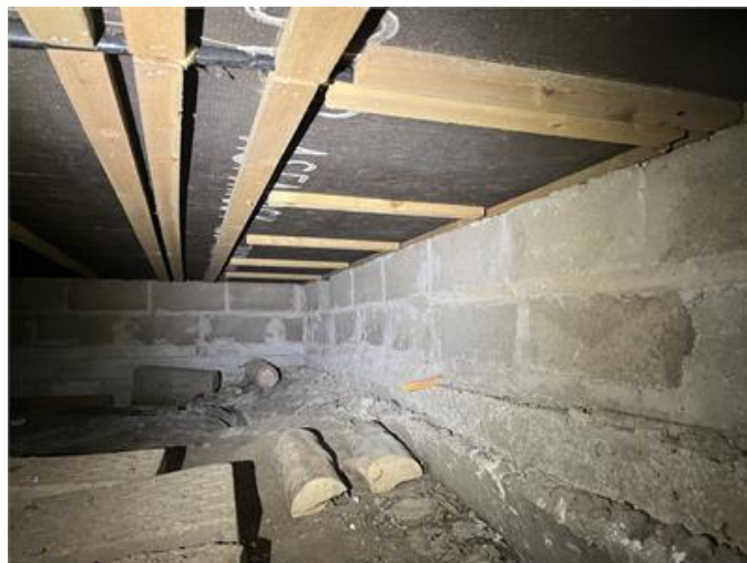
Bilden från krypgrunden.
