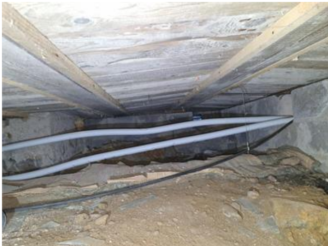
Krypgrund, översiktbild under Vardagsrum.
