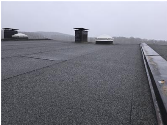
Yttertaket sett från stege mot takfot.
