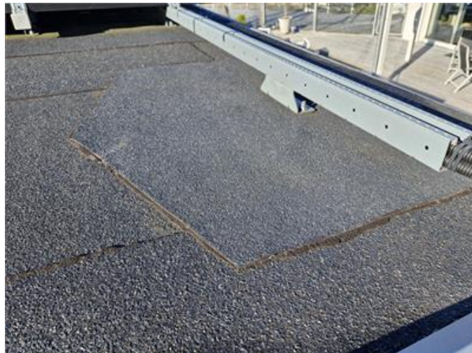
Tak, infästningar med takpapp ovan infästningsplåten.
