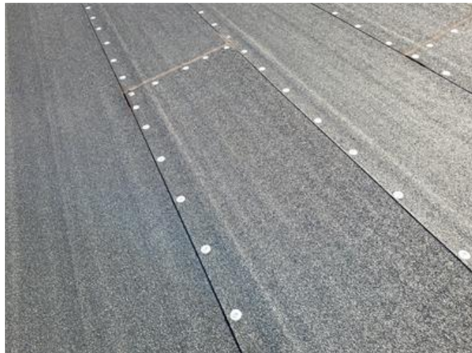
Papp förankrad med skruv.
