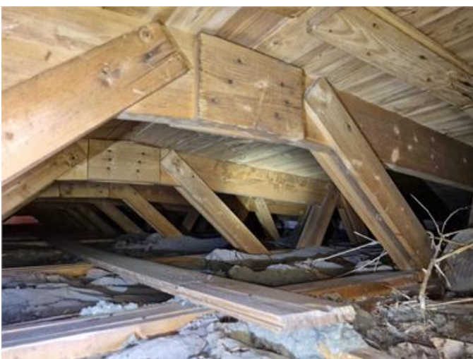
Nockvind, översiktsbild från luckan norra gaveln.
