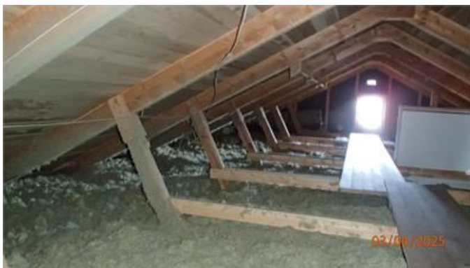
Bild på vinden. Vinden har tilläggs isolerats med lösull.
