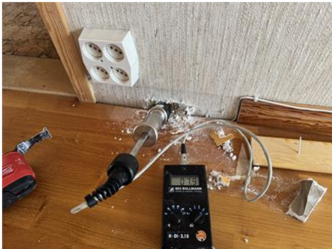
Fuktkvotsmätning i innerväggssyll.
