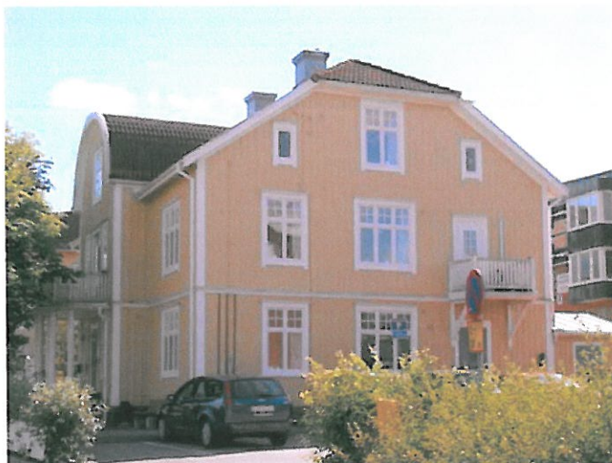
Gula husets norra fasad
