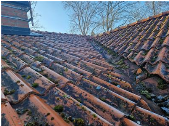
Vy på yttertak
