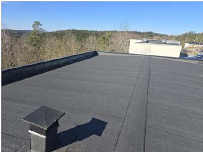
Översiktsbild yttertak, hus.
