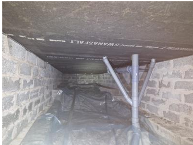
Krypgrund, översiktsbild västra delen.
