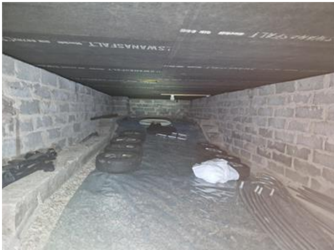
Krypgrund, översiktsbild östra delen.
