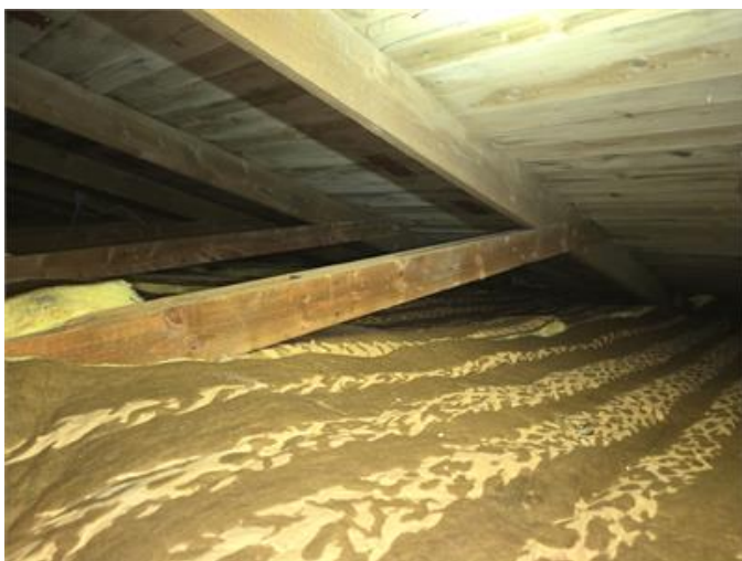
Exempel från del av vinden.
