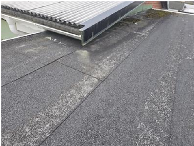
Överblick papptak. Ytan är uttjänt och spröd.
