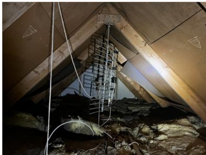
Underlagstaket består av träfiberskivor.
