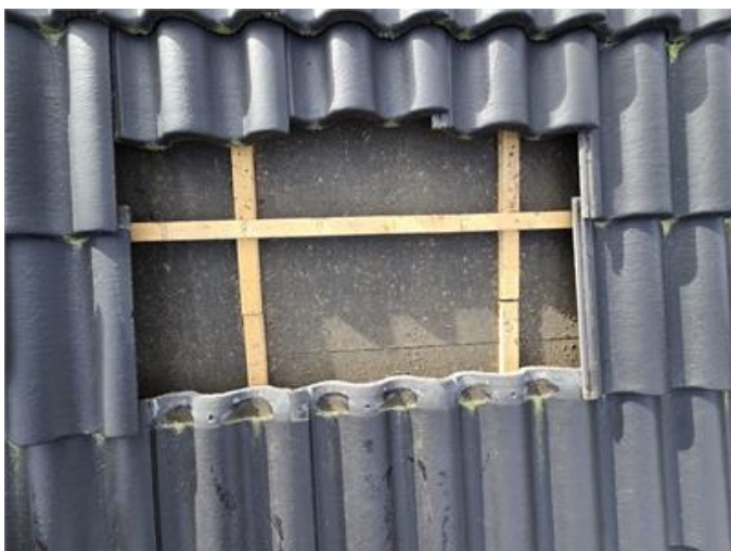
Tak: Stickprovskontroll under pannor.
