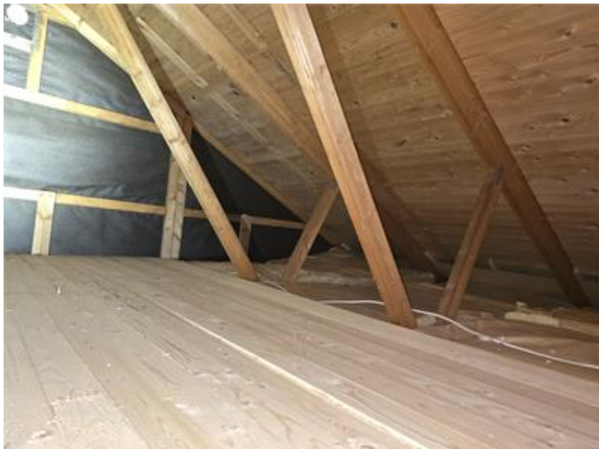
Överblick del av vind.
