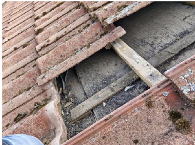
Tak, original takpannor med mossor, underlagstak av träfiberskivor.
