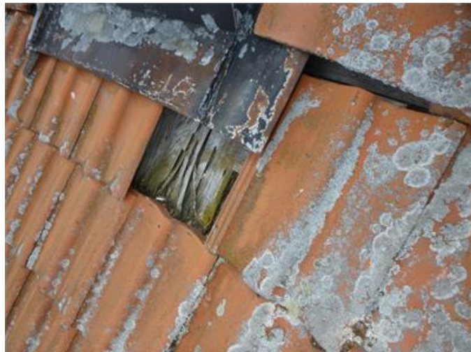
Nergliden takpanna kring skorsten med underlagstak av sticketak
