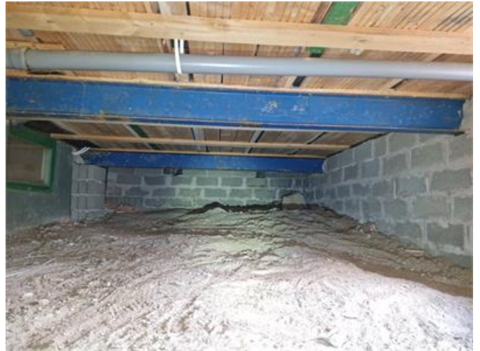
Krypgrund, översiktsbild norra utbyggnaden.
