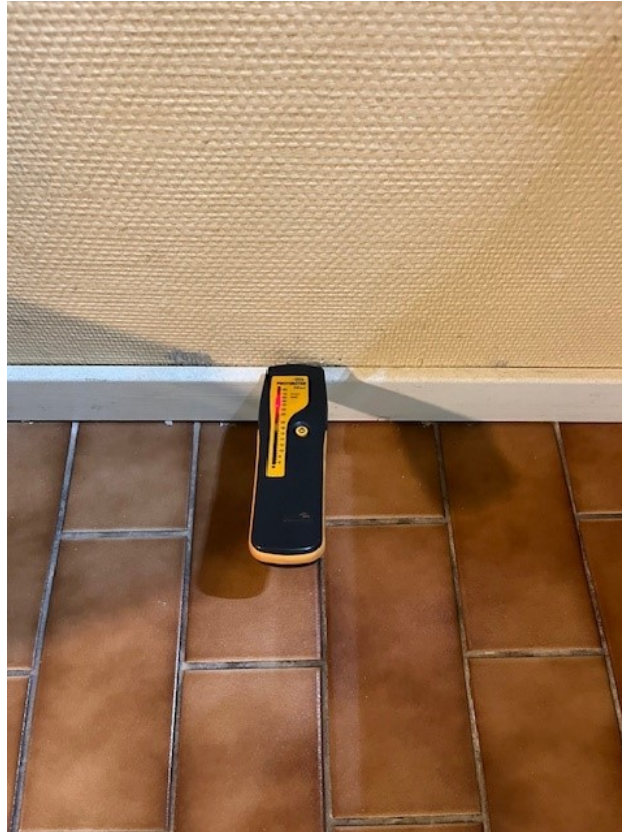
Fuktmätning i utreglad vägg mot framsidan.
