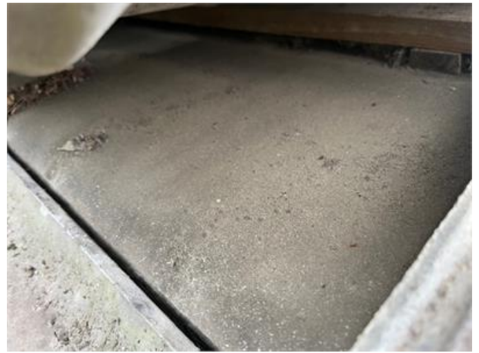
Tak tillbyggnad 70-tal- Stickprovskontroll av läkt och takpapp utförd utan något att anmärka på
