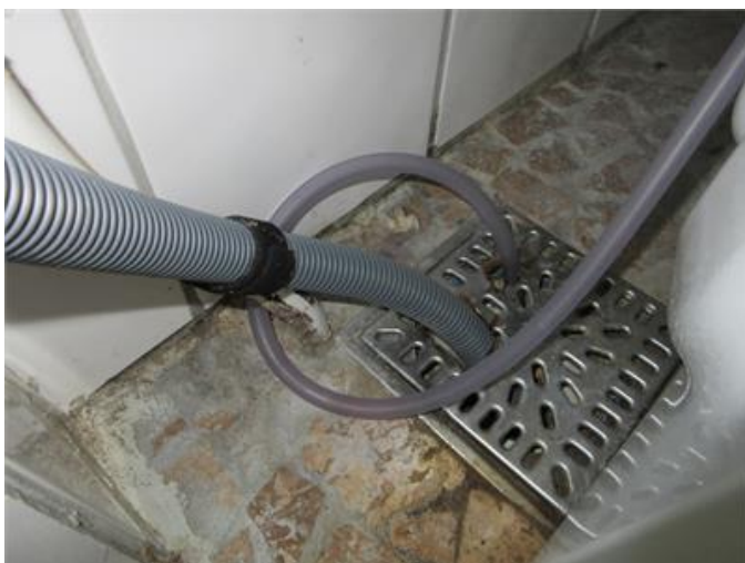
Golvbrunn monterad nära vägg samt rörgenomföring i golv.
