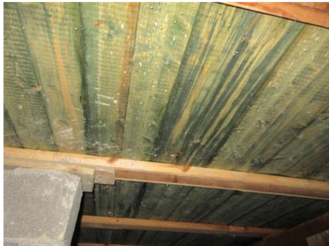
Rötskyddsbehandlat bjälklag (Kuprinol) i krypgrund
