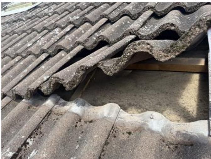
Taket är i originalutförande. Underlagstaket består av träfiberskivor (typ plywood).
