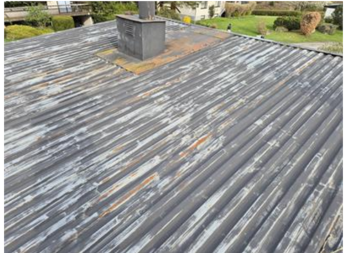
Bild över del av låglutande korrugerade plåttaket.
