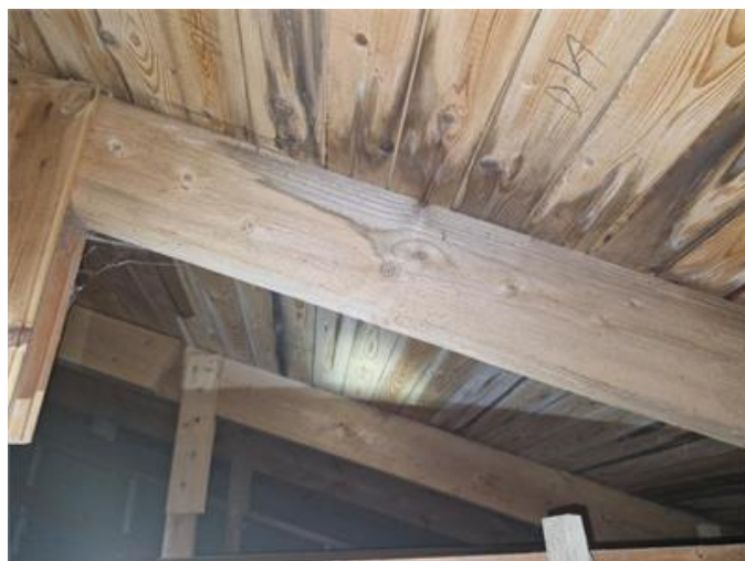
Nockvind, fuktanvisningar finns, torra vid stickprovsmässig kontroll.
