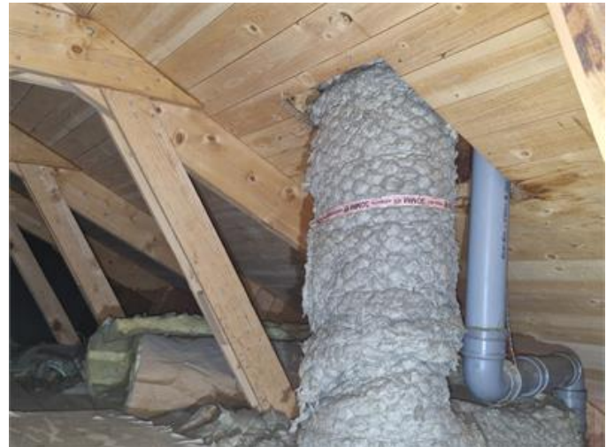
Nockvind, fuktanvisningar i underlagstaket och huv vid genomföring ventilation.
