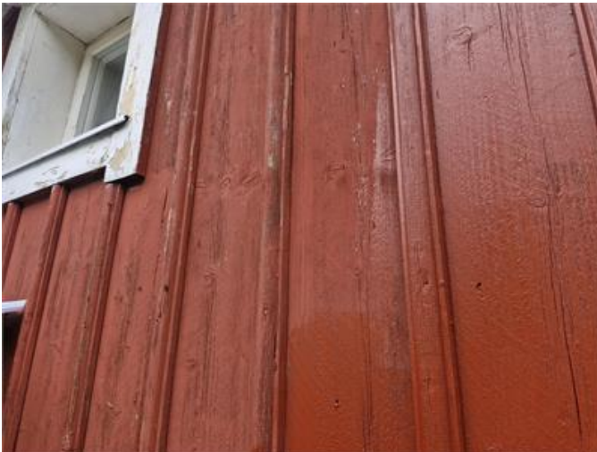
Fasad, äldre fasad med torrsprickor och färgsläpp där målningsarbete pågår.
