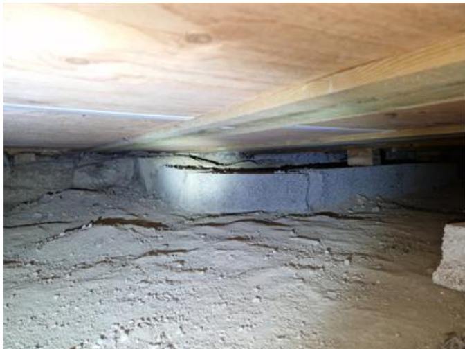
Torpargrund, översiktsbild under Tvätt.
