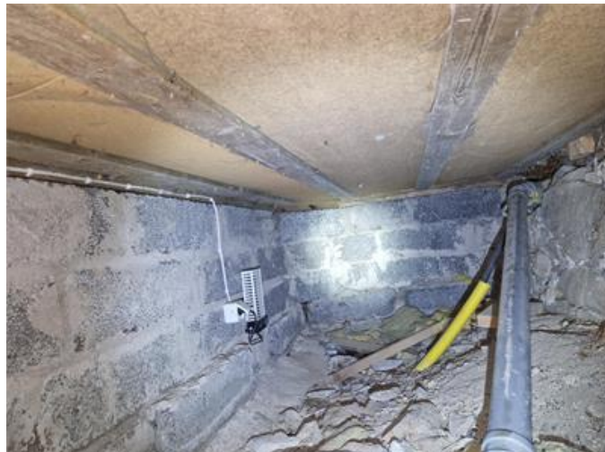
Torpargrund, översiktsbild under burspråk Kök.
