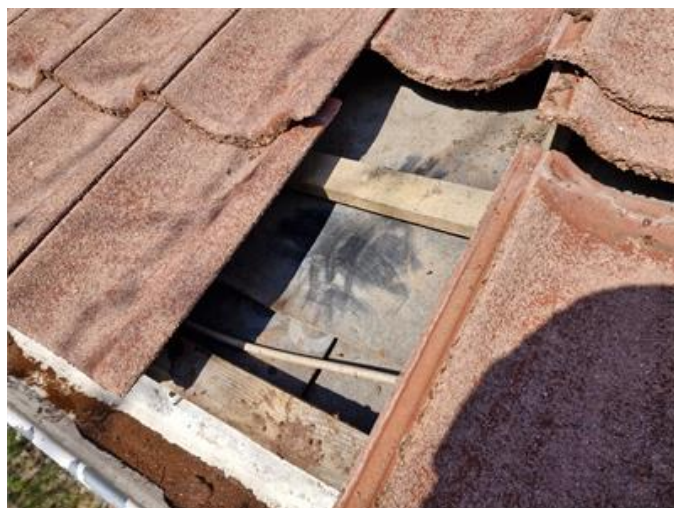
Tak, underlagstak av boardskivor.
