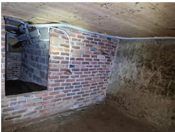
Torpargrund, översiktsbild under Hall.
