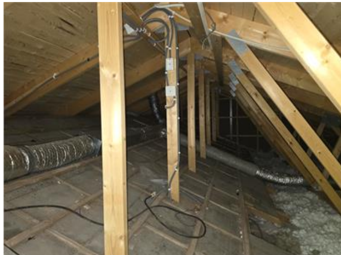
Överblick del av vind.
