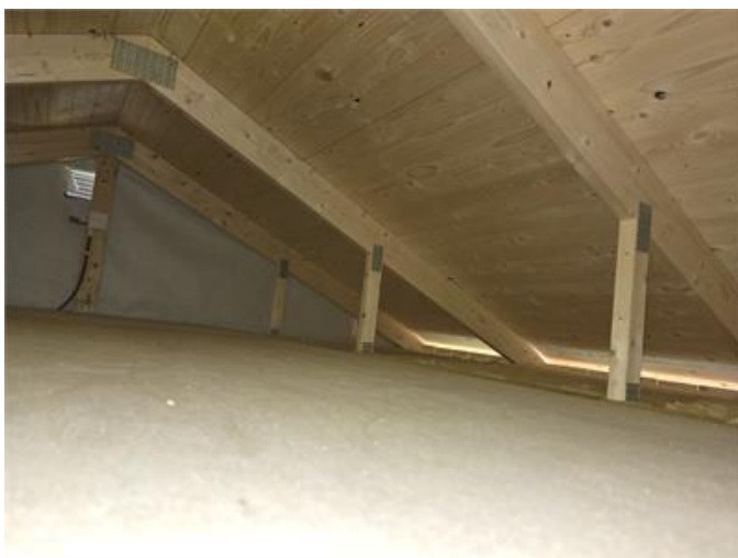
Överblick del av vind på garaget.
