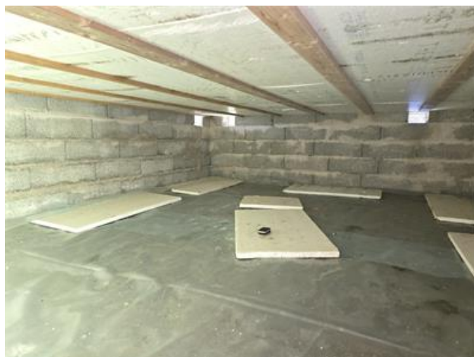
Överblick krypgrund under matplats.
