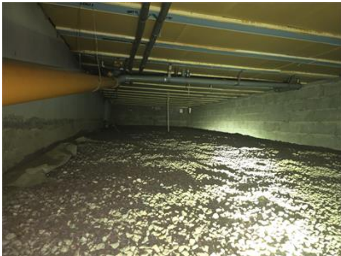
Överblick del av en krypgrund.
