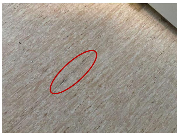
Bild 9: Invändigt, Entréplan, Tvättstuga, Finns några otätheter i svetsad skarv av våtrumsmattan.
