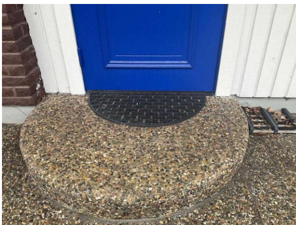
Bild 2: Utvändigt, Fasad, Träpanel är placerad nära trappan till groventrén, vilket ökar risk för fuktrelaterade skador.
