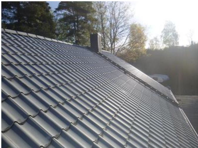
Bilden visar vy av plåttäckningen.
