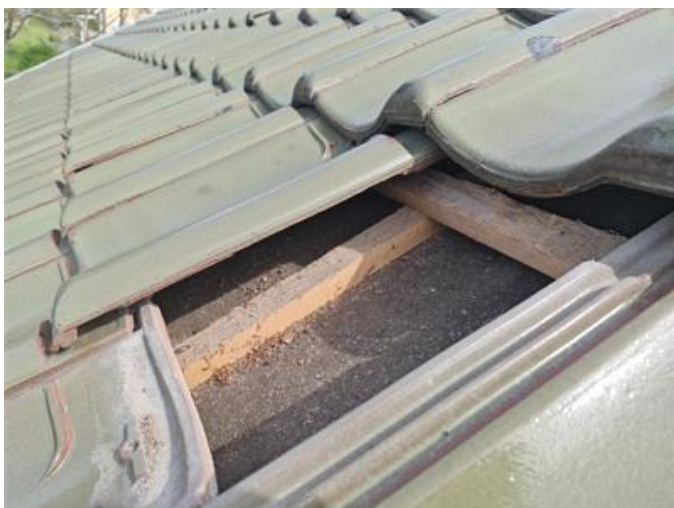
Tak, kontroll under takpannor, inget att notera.
