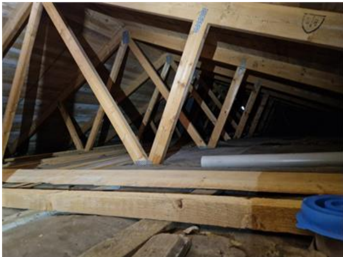
Vy på vindsutrymmet
