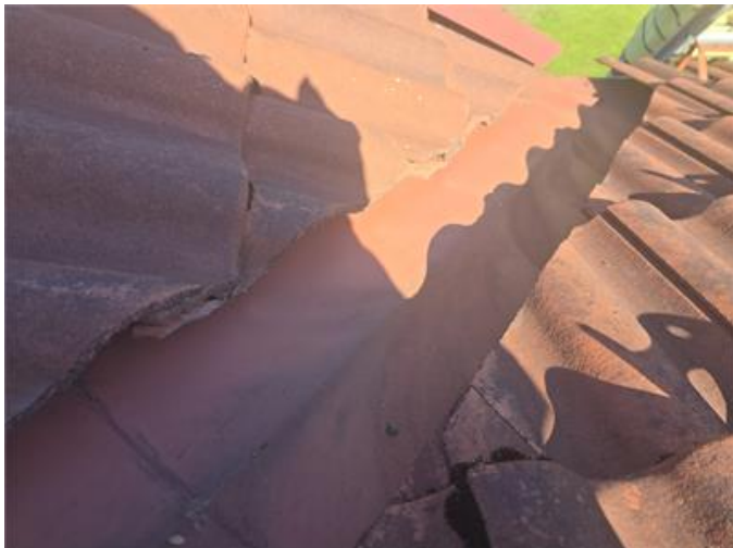
Exempelbild sprucken takpanna intill vinkelränna.
