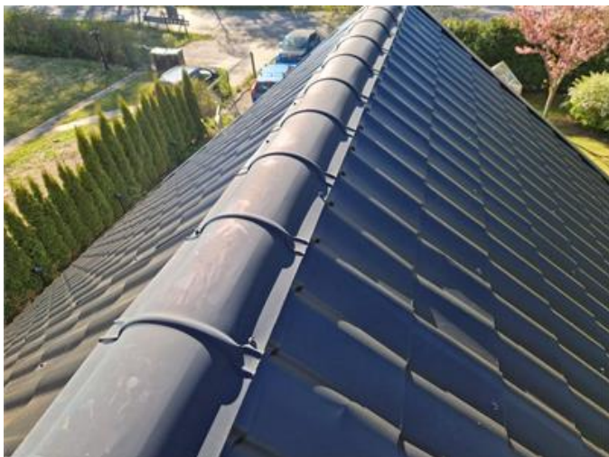
Vy på yttertak
