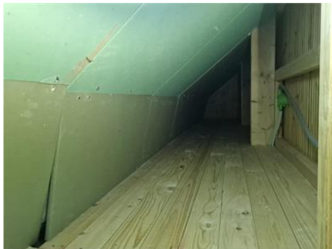
Vy på förråd/sidovind
