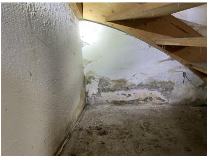
Dränering och utvändigt fuktskydd mot källarytterväggar runt om huset är det ursprungliga. Se kommentarer och riskanalys.
