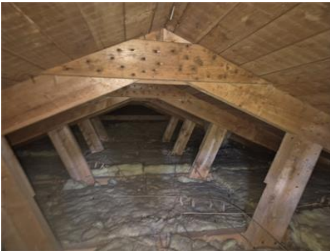
Bild från vind tillbyggnad.
