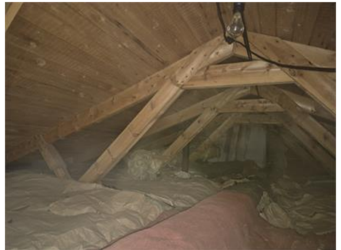
Bild från vind ursprunglig byggnad.
