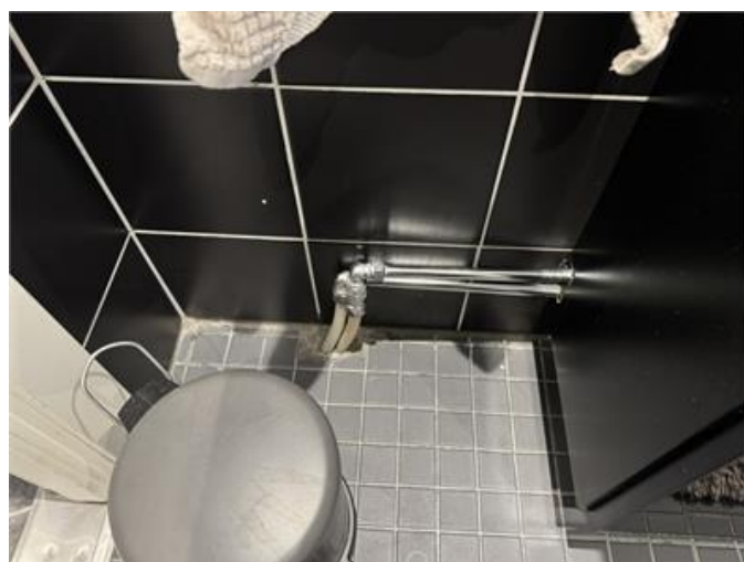
Rör genomföringar i golvet i WC/dusch.
