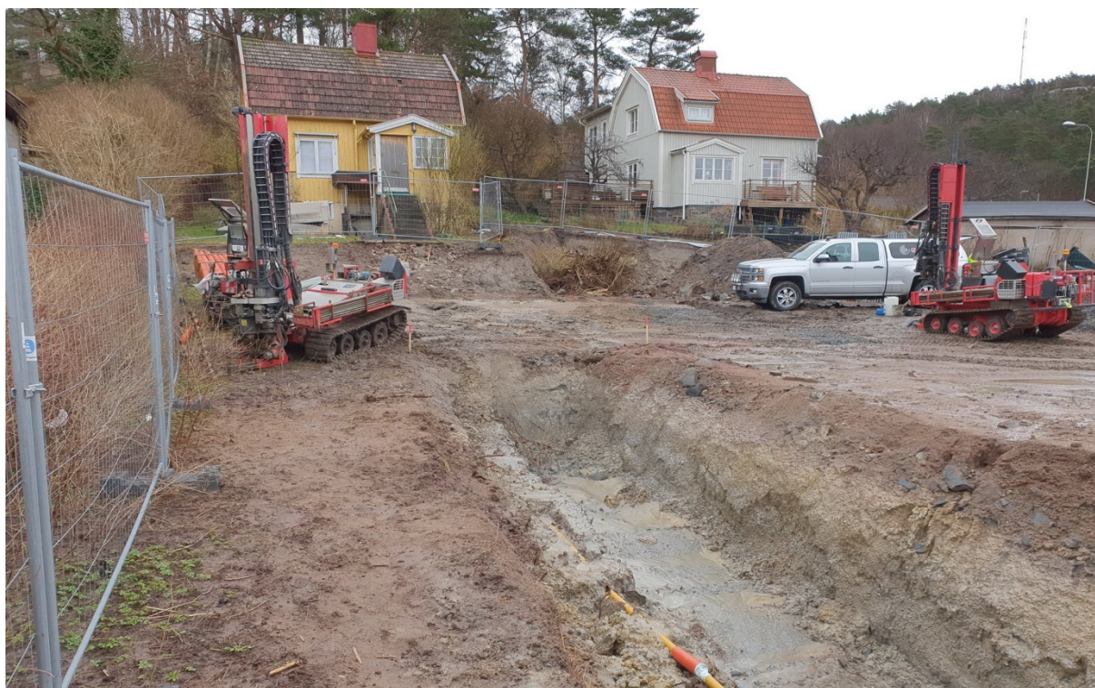
Bild 2. Påbörjade markarbeten där befintliga VA-ledningar delvis grävts fram.
