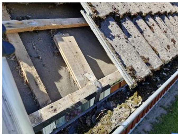
Tak, kontroll under pannor.
