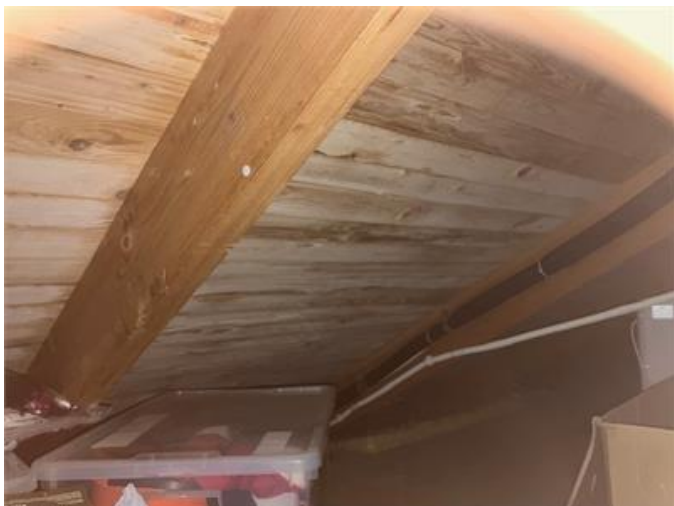
Mikrobiell påväxt på sidovinden
