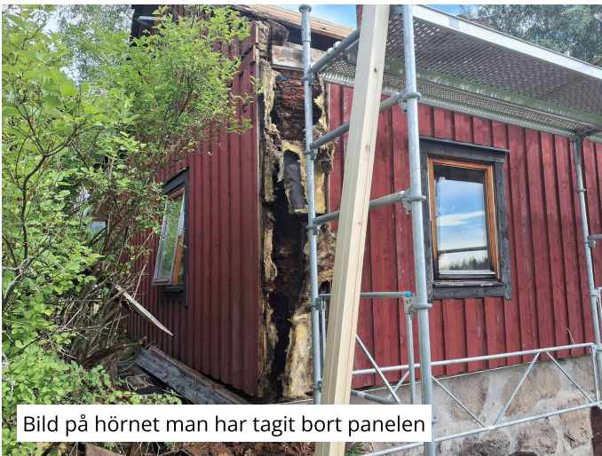
Rötskador i timmerstomme
