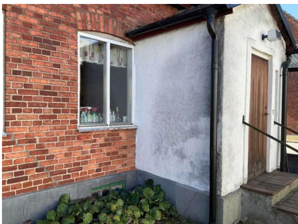
Bild 1: Utvändigt, Fasad, Missfärgningar på putsad fasad.
