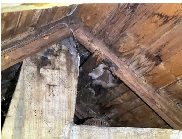
Bild 4: Utvändigt, Vind, Missfärgningar/fuktgenomslag finns på insida yttentak.
