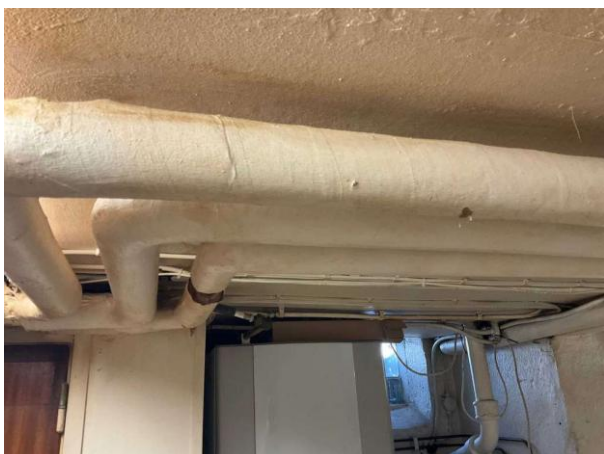
Bild 11: Invändigt, Källarplan, Allmänt, Kan eventuellt förekomma installationer som erhållits med asbesthaltigt material (isolering på vattenledningar).
