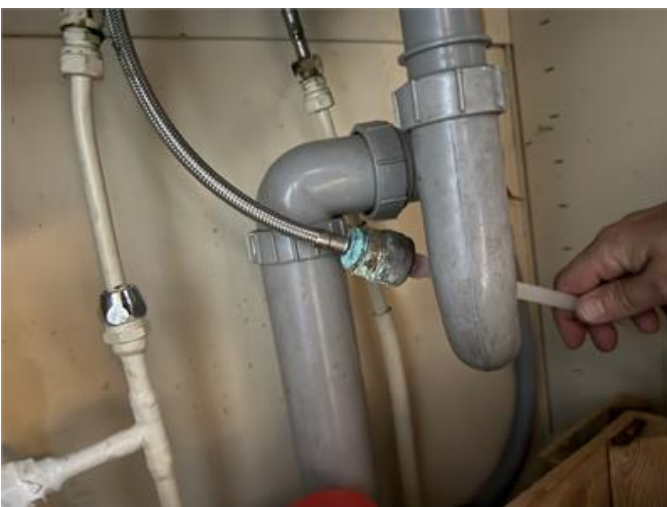
Årgad rörkoppling noterades i diskbänkskåpet.
