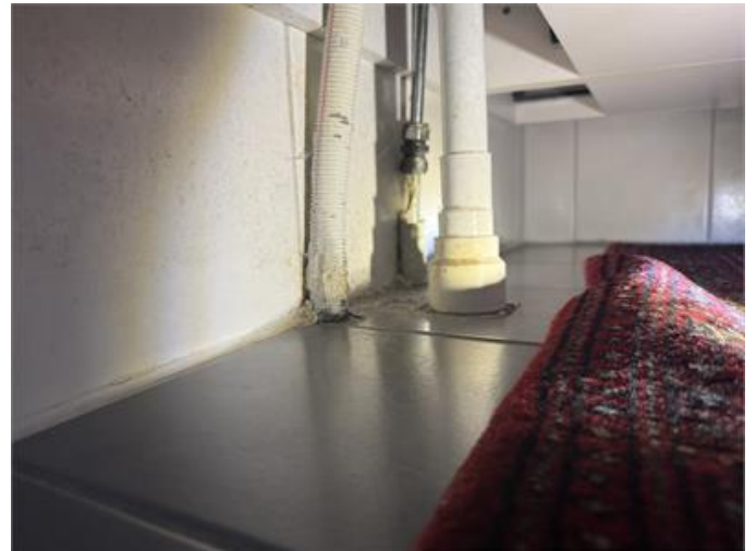
Rör genomföringar placerade i golv-/väggvinkeln (entréplan).
