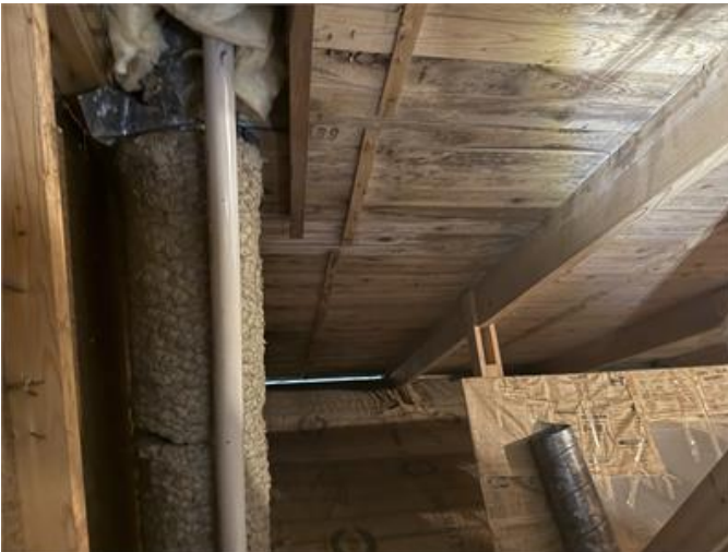
Det förekommer mikrobiell påväxt på underlagstaket insida.
